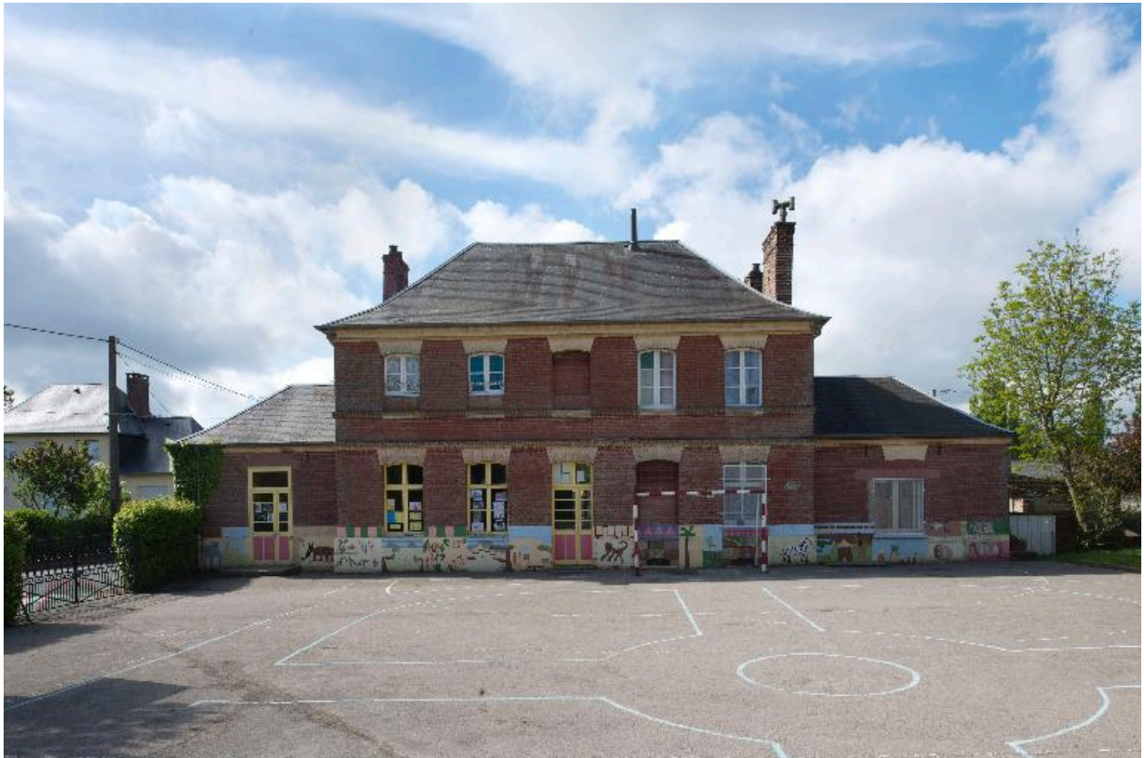
Vue de l'élévation nord.
