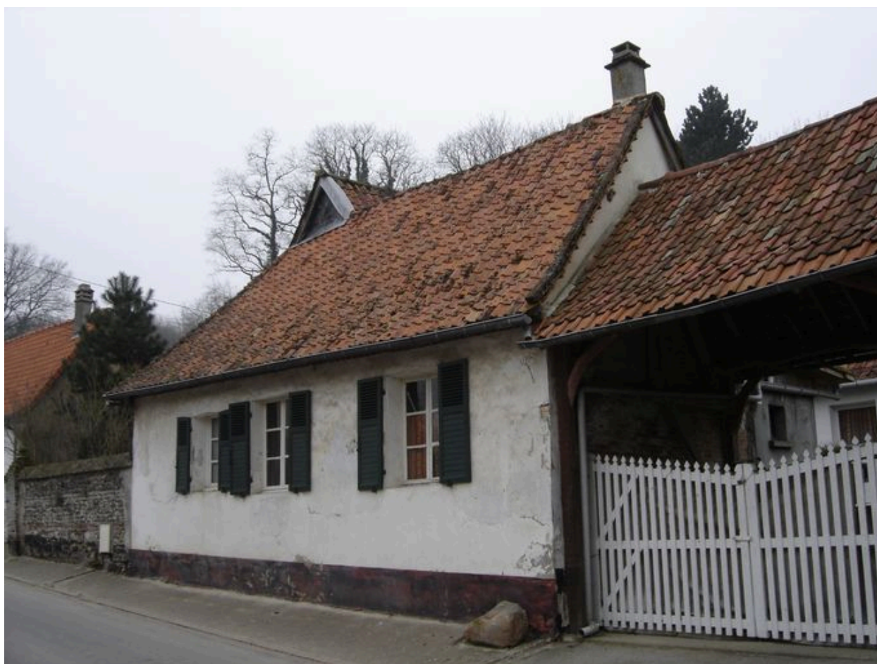
Vue du logis sur rue.
