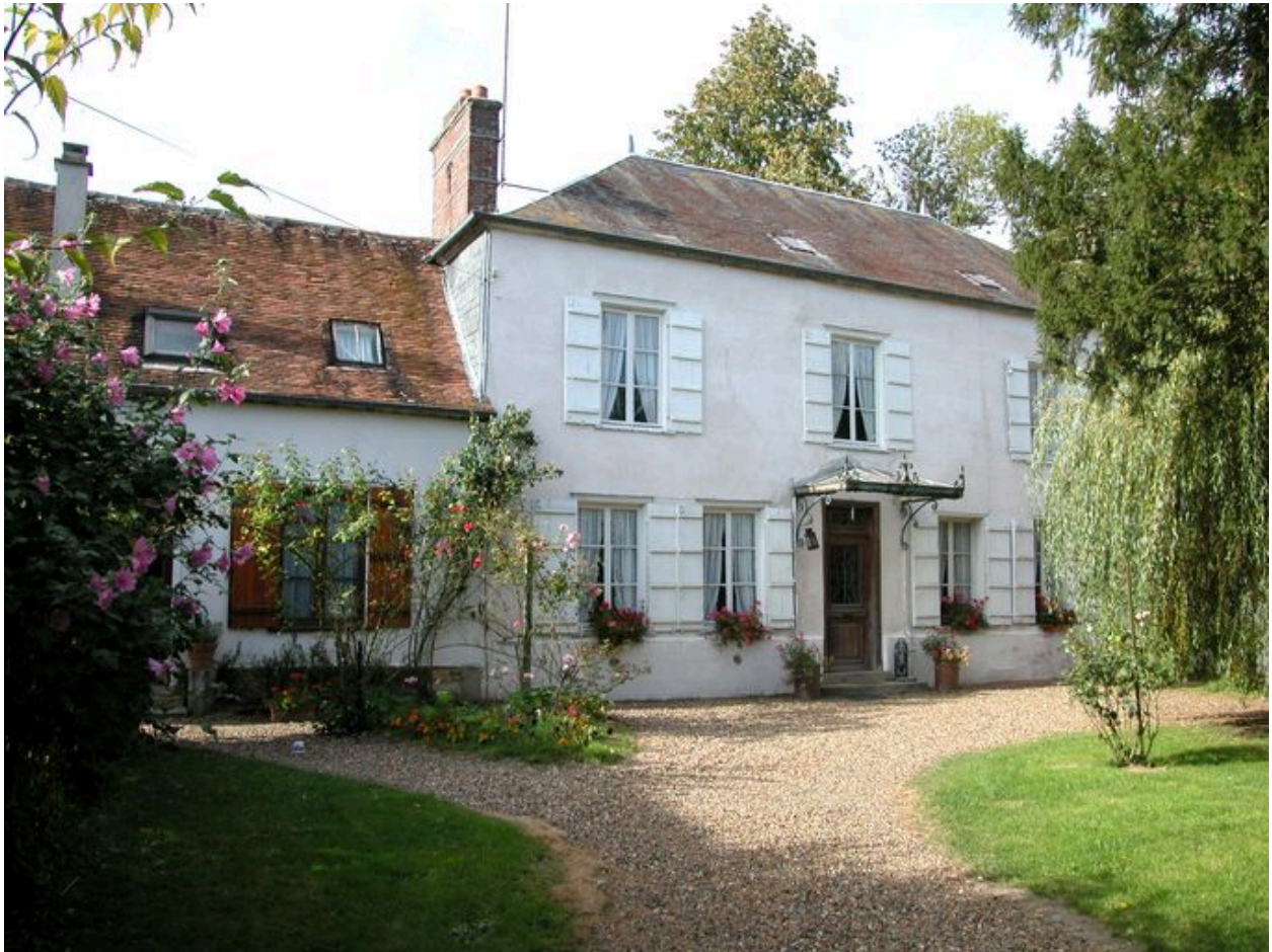
L'atelier de fabrication et le logement du meunier, façade sur cour.
