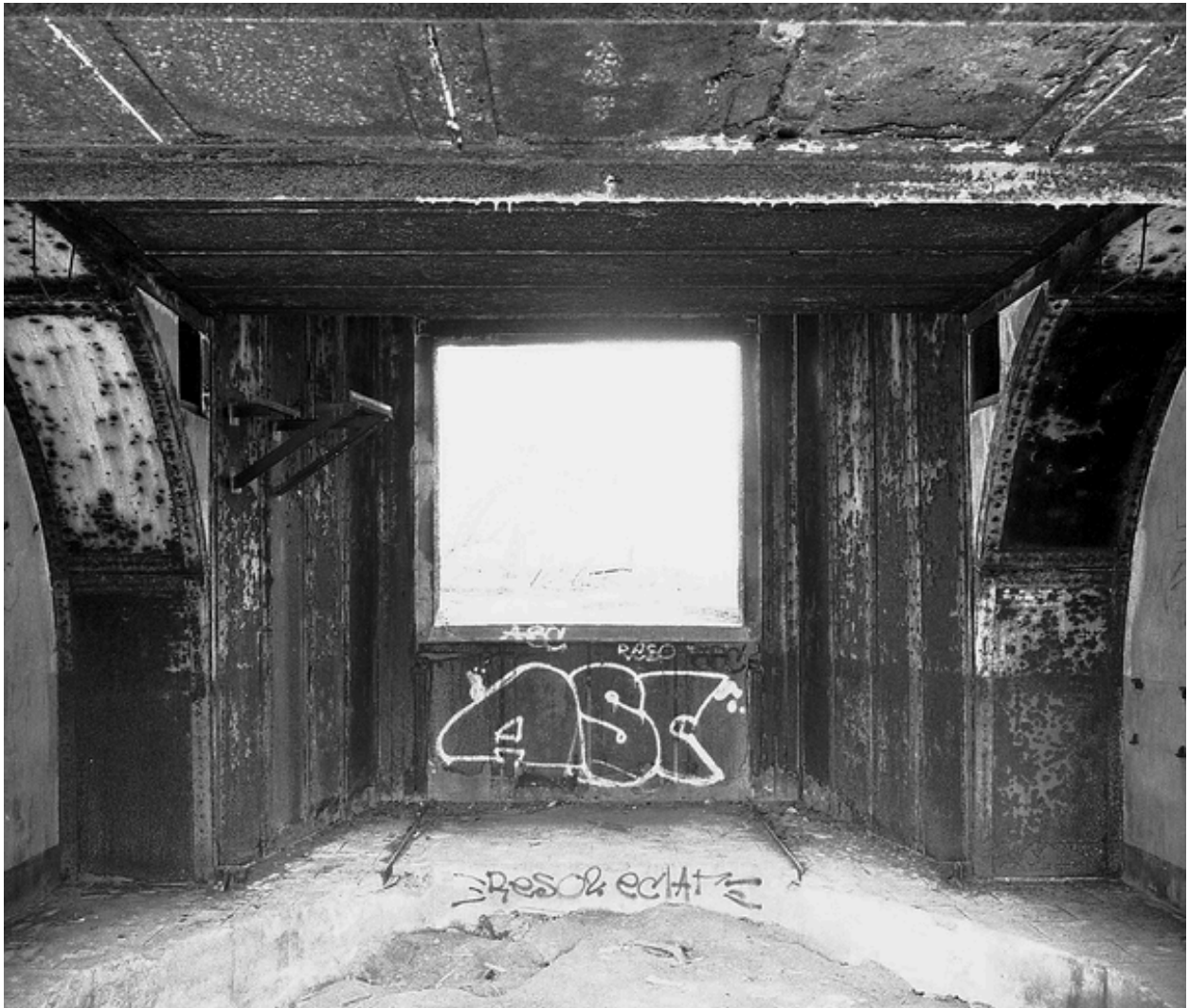
Vue générale de la chambre de tir : l'embrasure et la fosse de recul.
