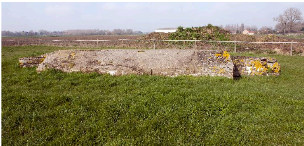
Casemate nord, vue vers l'ouest
