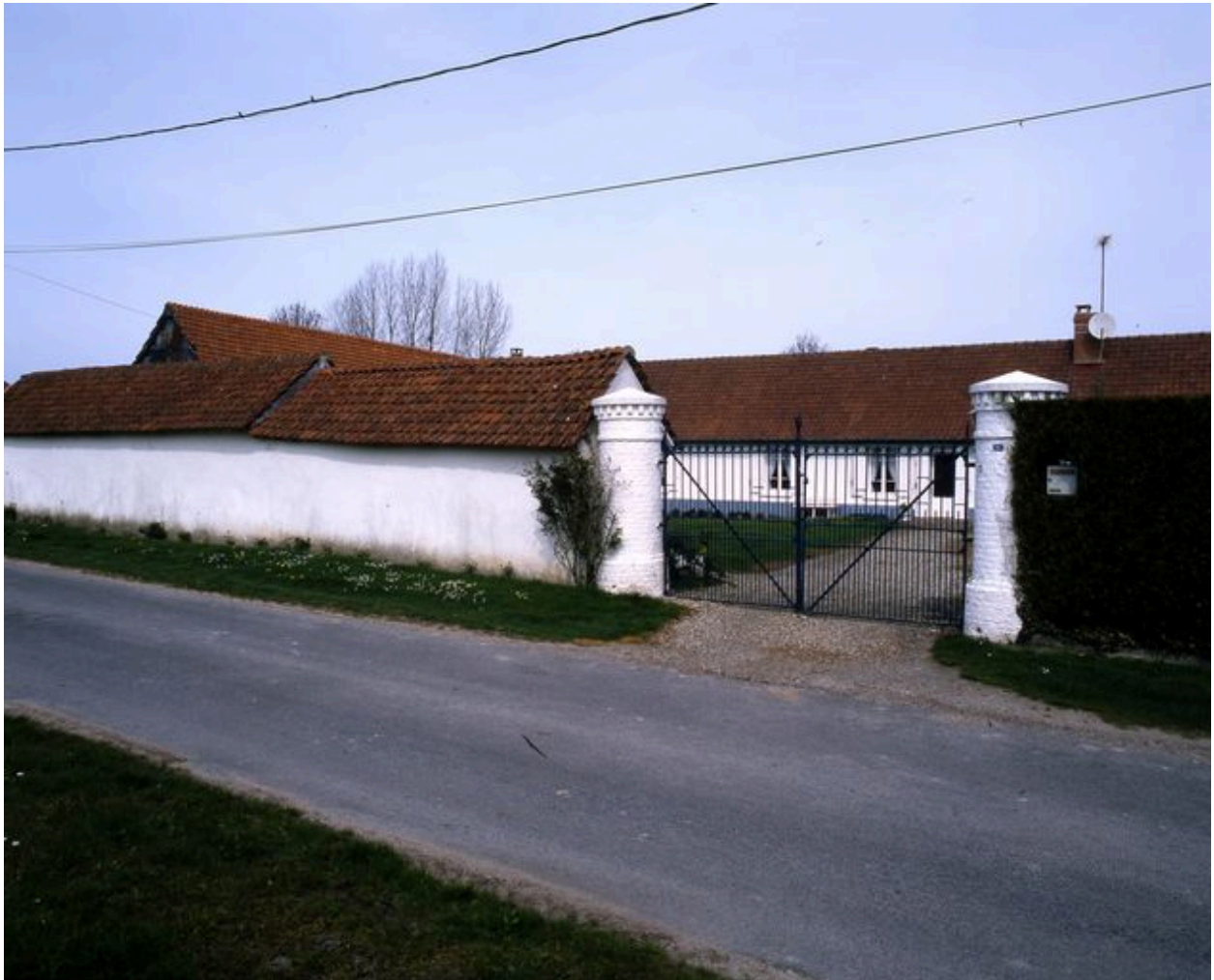
Vue d'un des deux piliers d'entrée et des étables à cochons sur rue.
