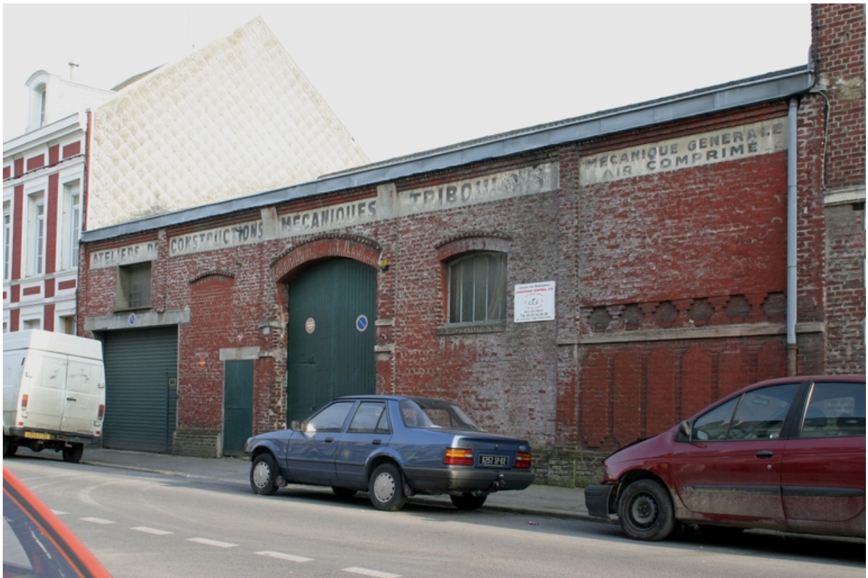
Façade antérieure des ateliers.
