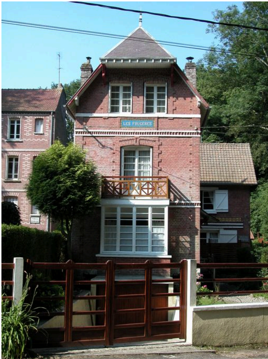
Vue d'ensemble depuis la route du Vieux-Chêne.
