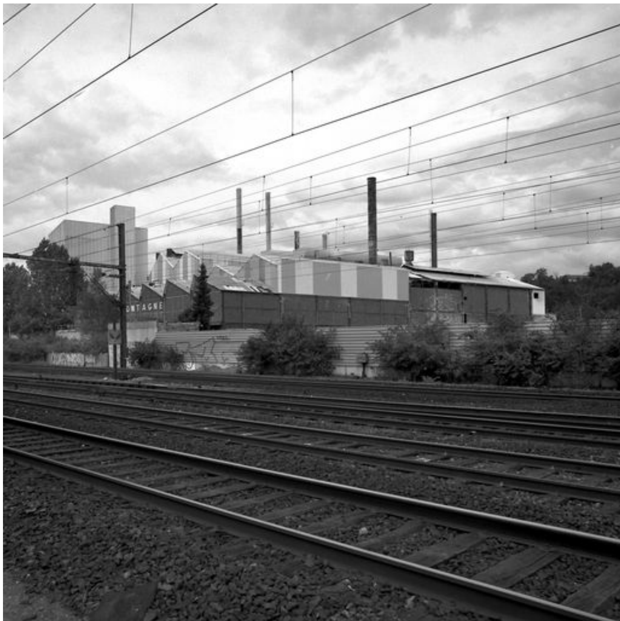
Bâtiments abritant les fours Waelz et la colonne New-Jersey, pris depuis la voie ferrée.
