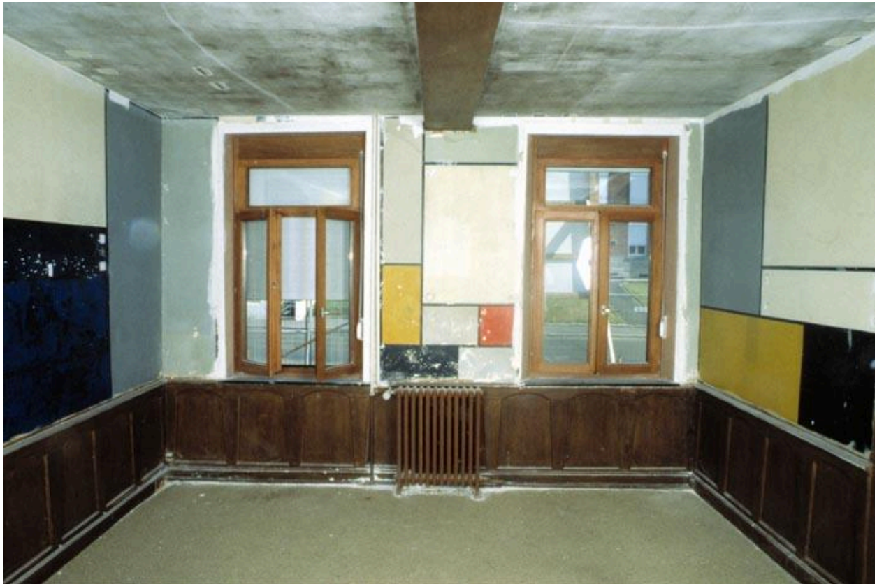
Pièce décorée par Félix Del Marle (1889-1952) : vue générale du mur 4 en cours de restauration (août 2001).
