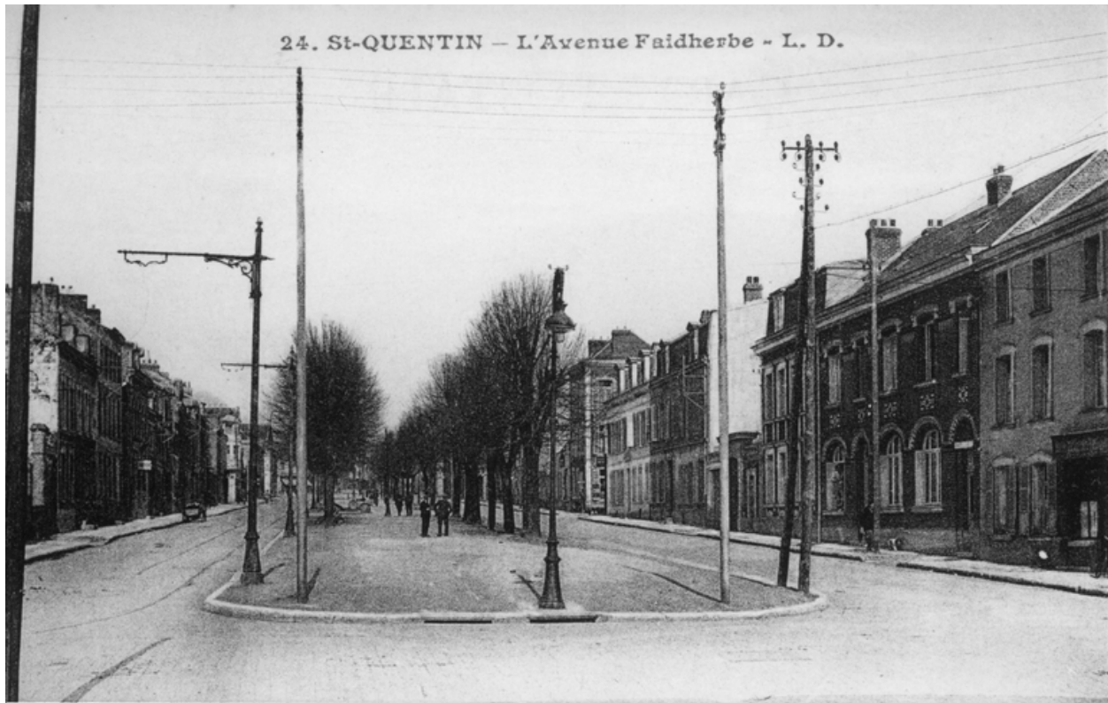
Vue du site, avenue Faidherbe, après la reconstruction (BM Saint-Quentin).
