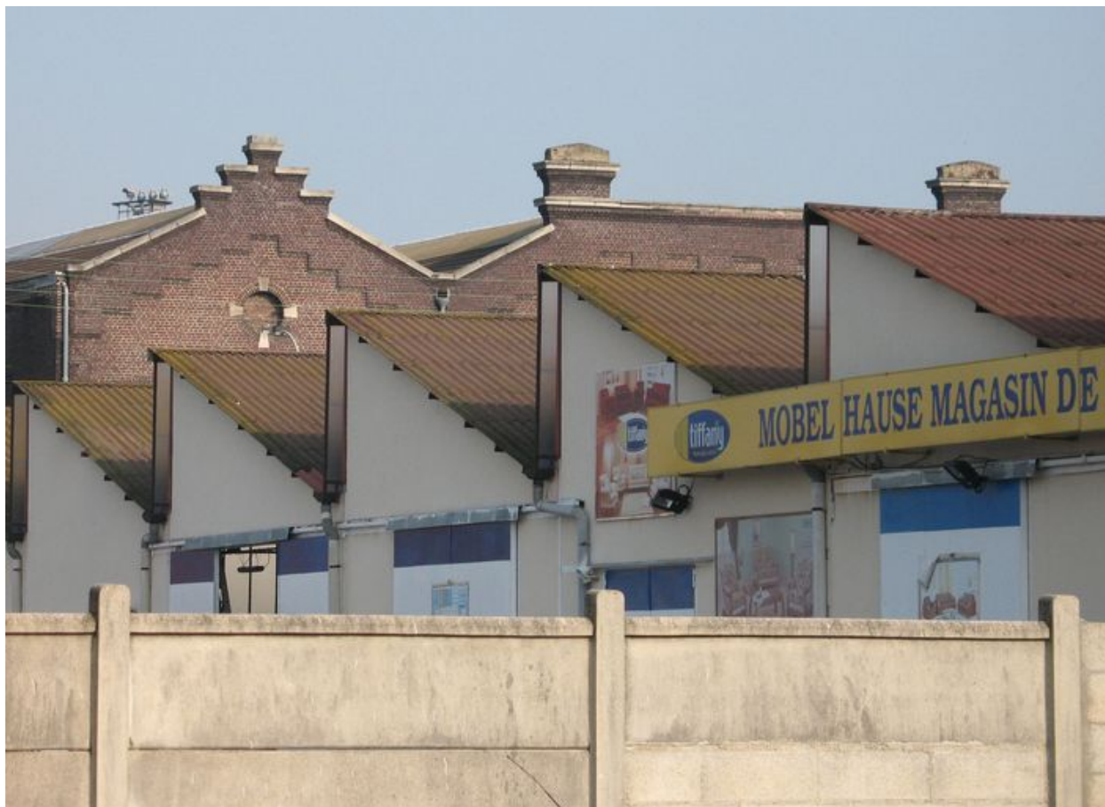
Détail de la couverture des sheds.
