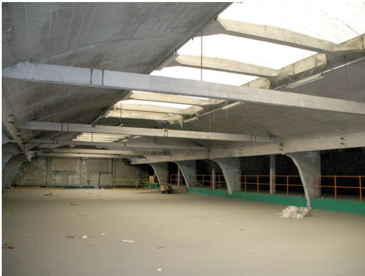
Voûte en béton et éclairage zénithal du bâtiment de la fonderie.
