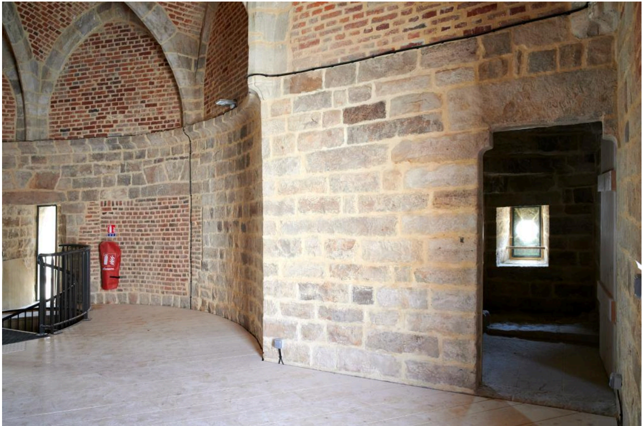
Vue en détail de l'ouverture menant aux escaliers de la terrasse supérieure, premier niveau.
