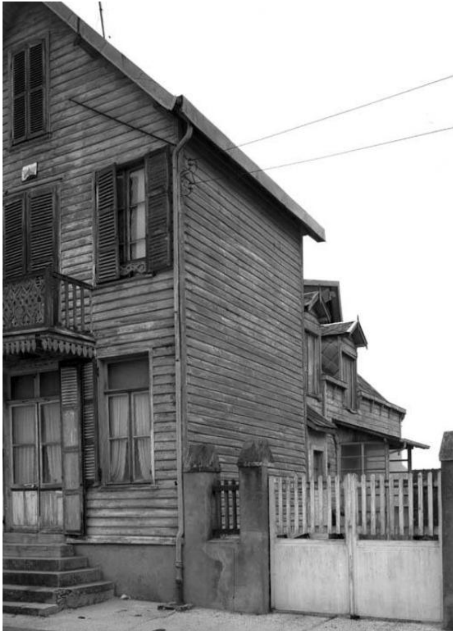
Façade latérale droite.
