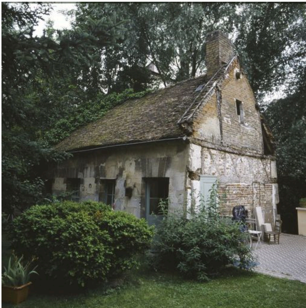
Bâtiment destiné au lavage des laines, vue d'ensemble sur cour.
