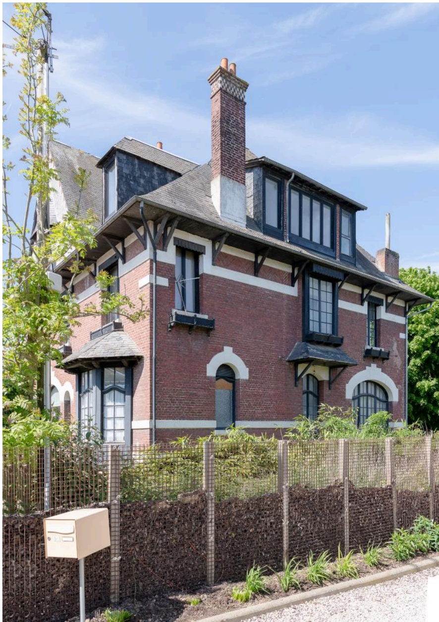
Vue de la façade latérale droite de la maison de maître depuis la rue du Maréchal-Leclerc.
