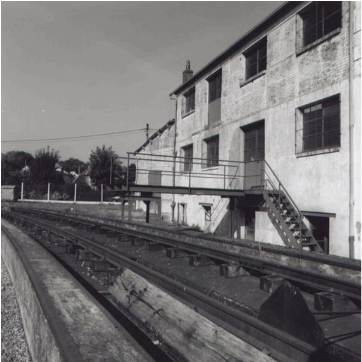
Le quai de chargement et l'embranchement ferroviaire.
