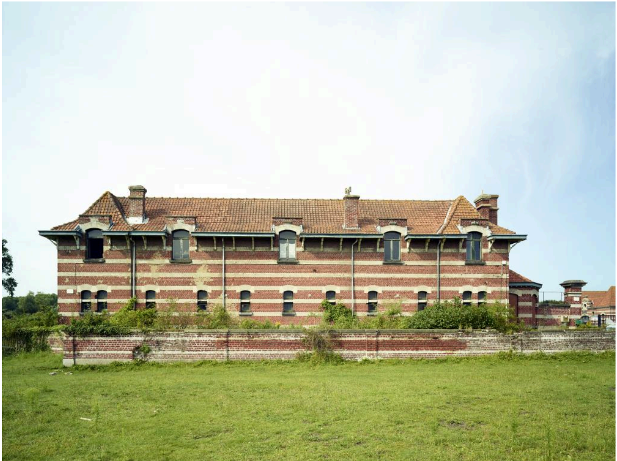
Vue d'ensemble sud des anciennes étables de la ferme et de la remise à matériel.
