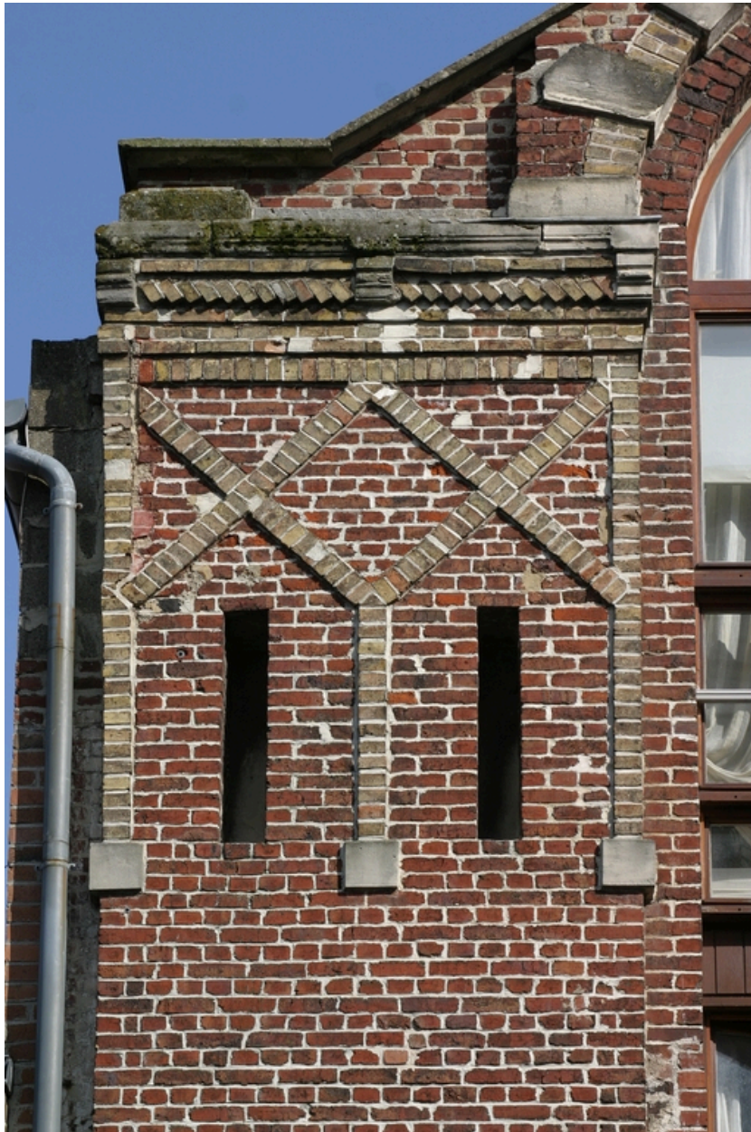
Maçonnerie des ateliers : détail.
