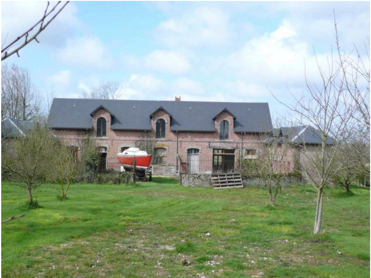
Vue des bâtiments agricoles depuis la rue de Forest-Montiers.
