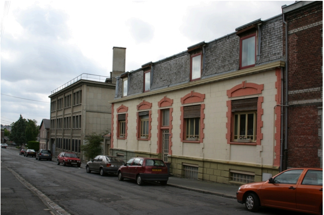
Logement patronal et chaufferie, rue Jacquard.
