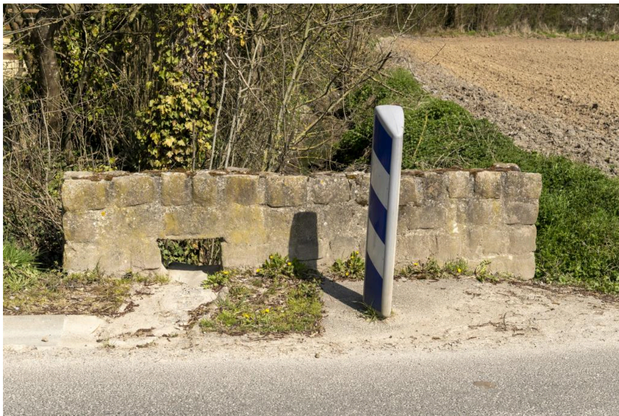
Ponceau, rue Principale à la sortie du village vers Fontaine-Bonneleau.
