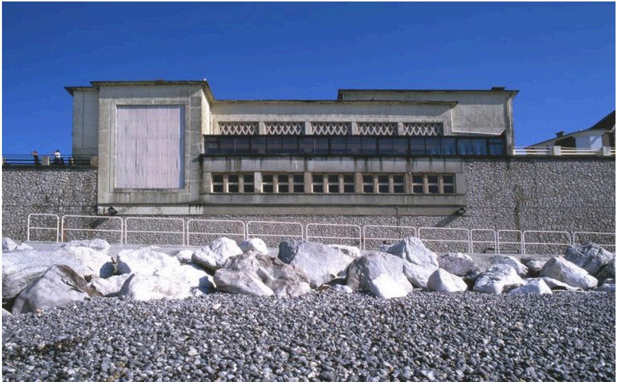
Vue générale, depuis la plage.
