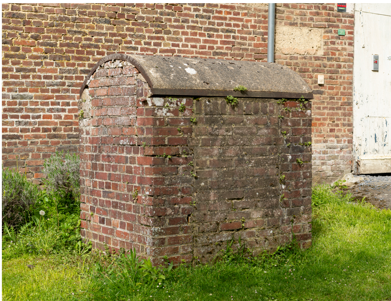
Puits avec réfection en brique, rue Becquerelle.
