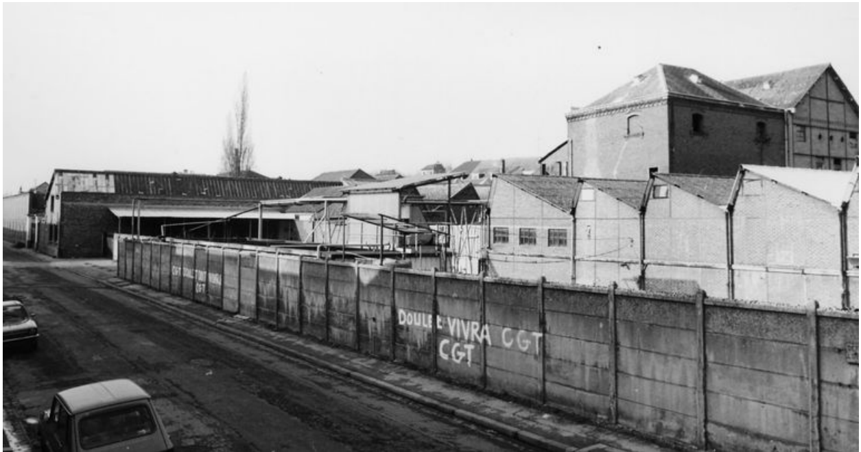
Les ateliers de fabrication, vus depuis le sud-est.
