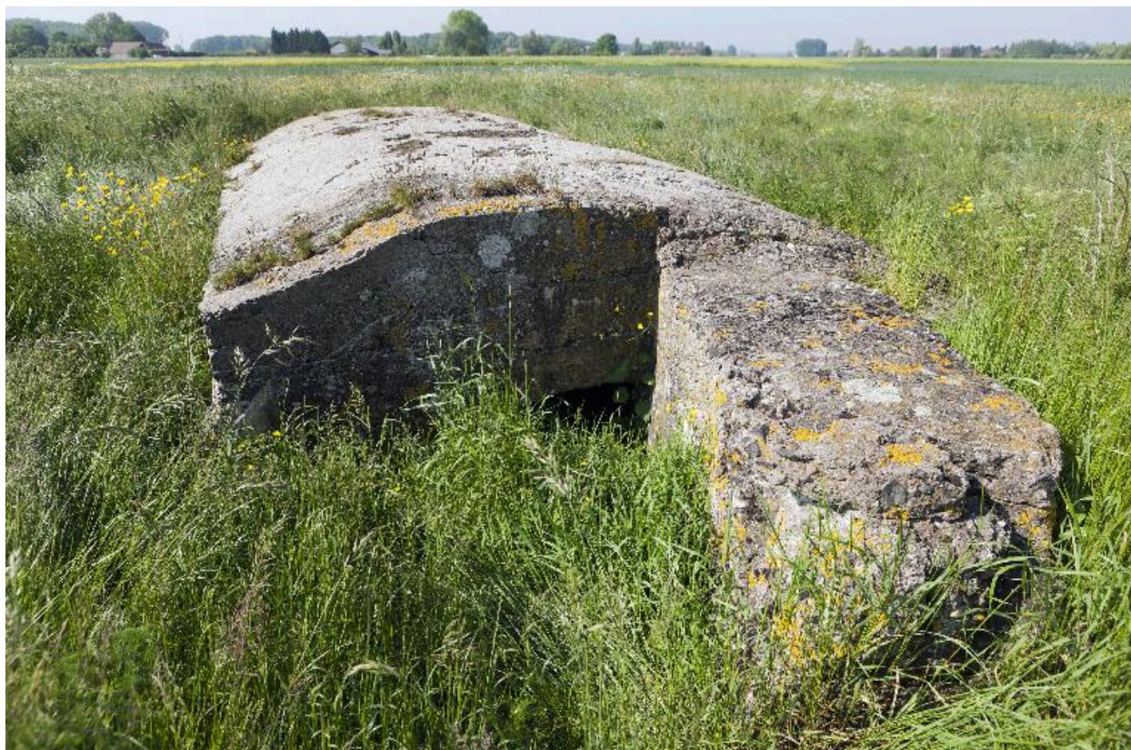
Casemate nord, entrée nord
