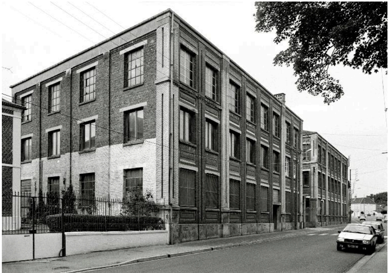
Façades l'usine, rue Roger-Salengro, en 1988.
