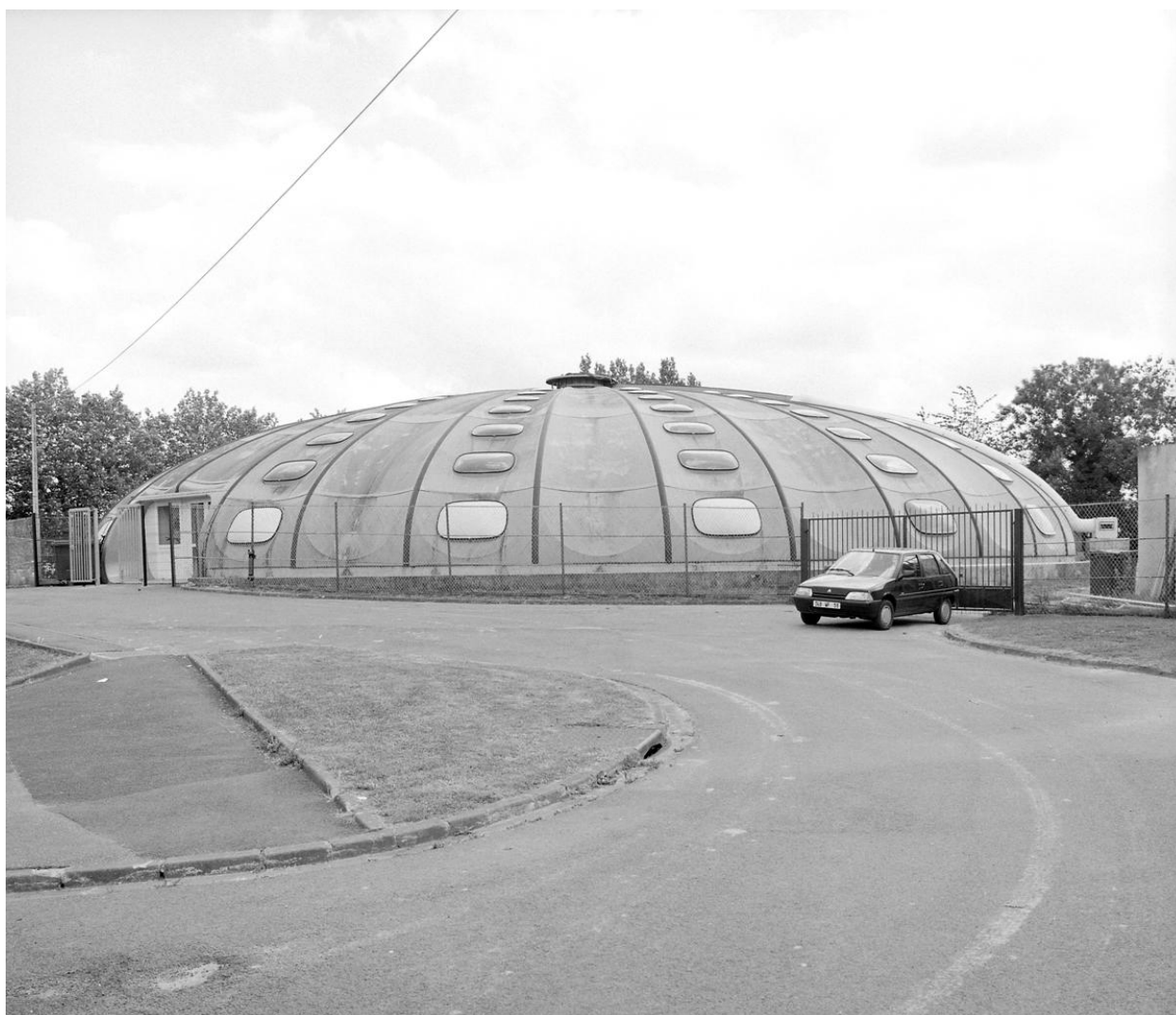
Vue générale de la piscine Tournesol place Léon-Blum (détruite).
