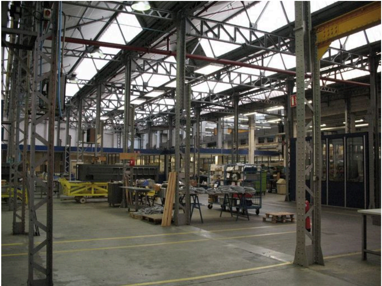
Ateliers avec couverture en sheds en dents de scie et poteaux en treillis métallique.
