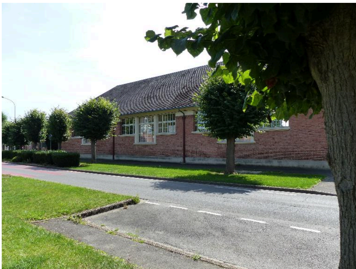
Le préau de l'ancienne école de garçons, vu depuis l'avenue Jean-Jaurès.
