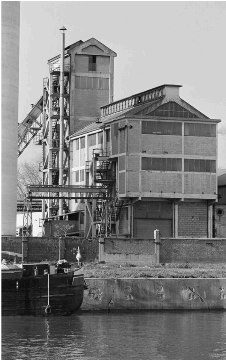
Atelier de fabrication : flanc est.
