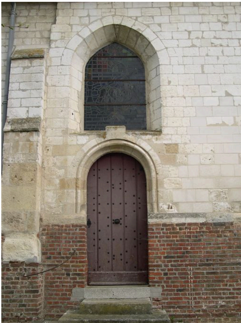
Porte sud de la nef.
