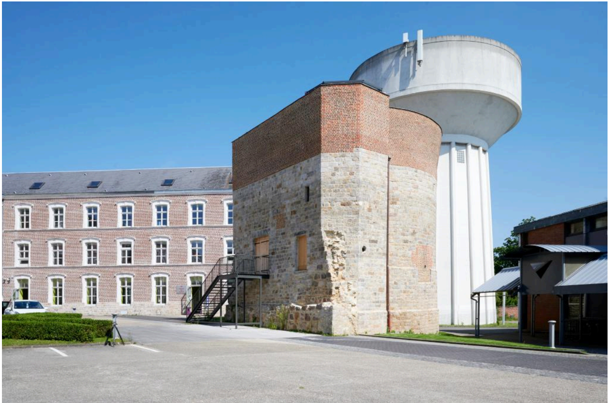
Vue générale du nord-est de la tour, prise depuis la cour du lycée.
