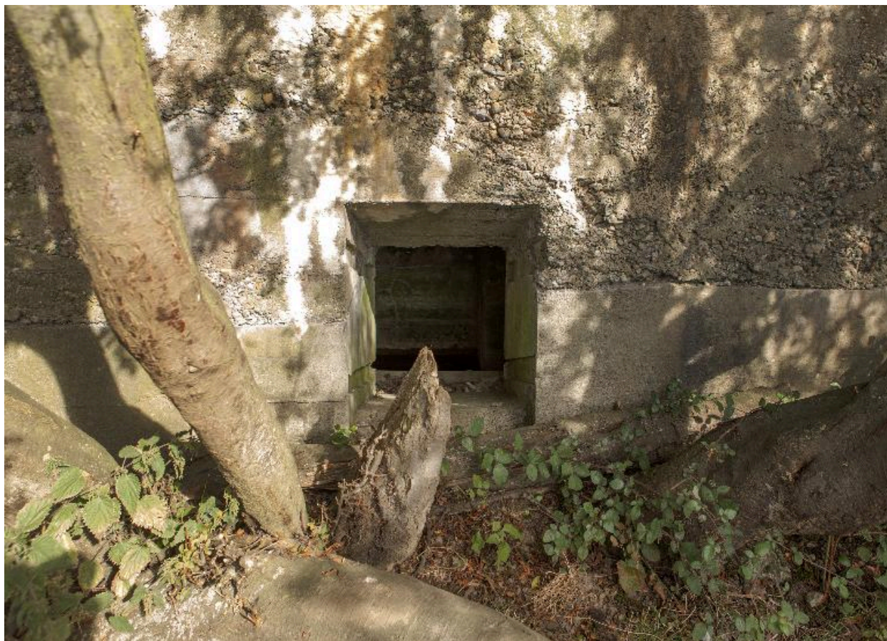
Ouverture dans l'élévation sud
