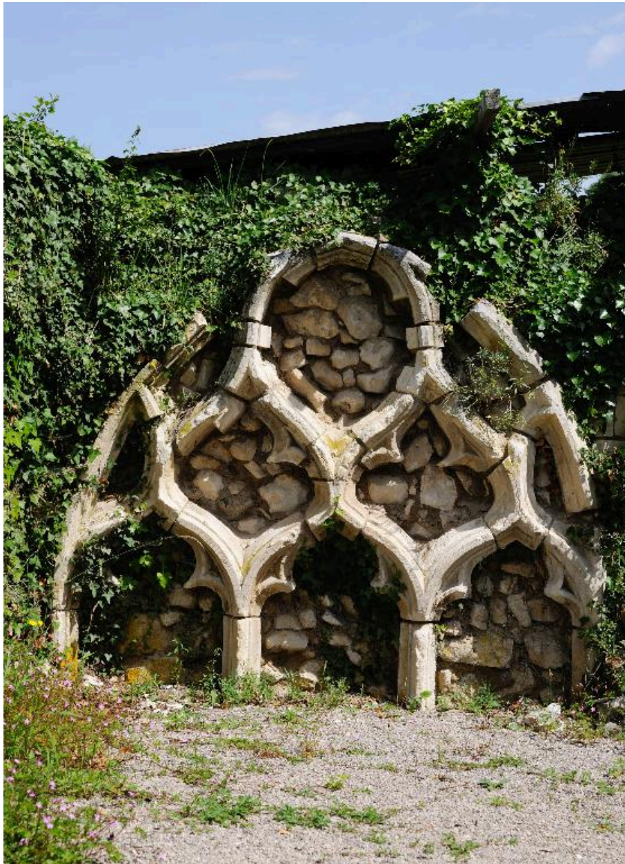
Eléments de baie flamboyante à remplage remontés dans le trésor.
