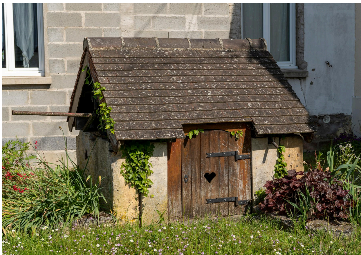
Ancien puits, face au n°29 rue de Provinlieu, vue depuis le sud-est.
