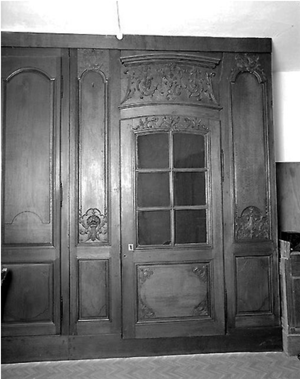
Sacristie : partie droite des lambris de revêtement.
