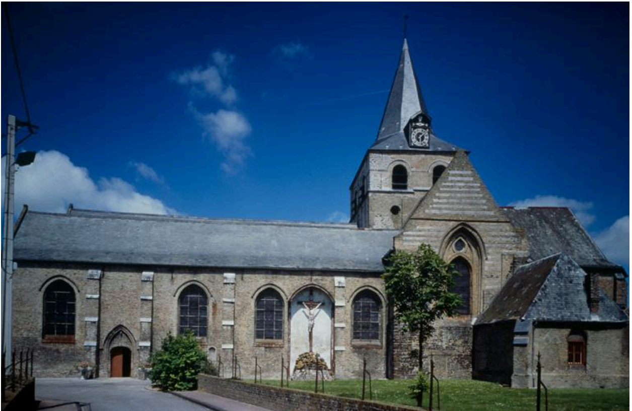
Vue générale de la façade sud.
