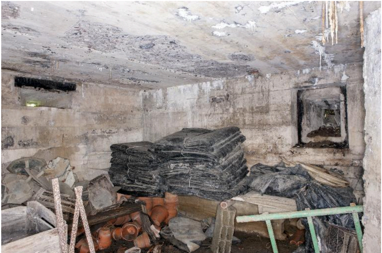
Salle nord : Créneaux de surveillance (à gauche) et de fusillade (à droite)
