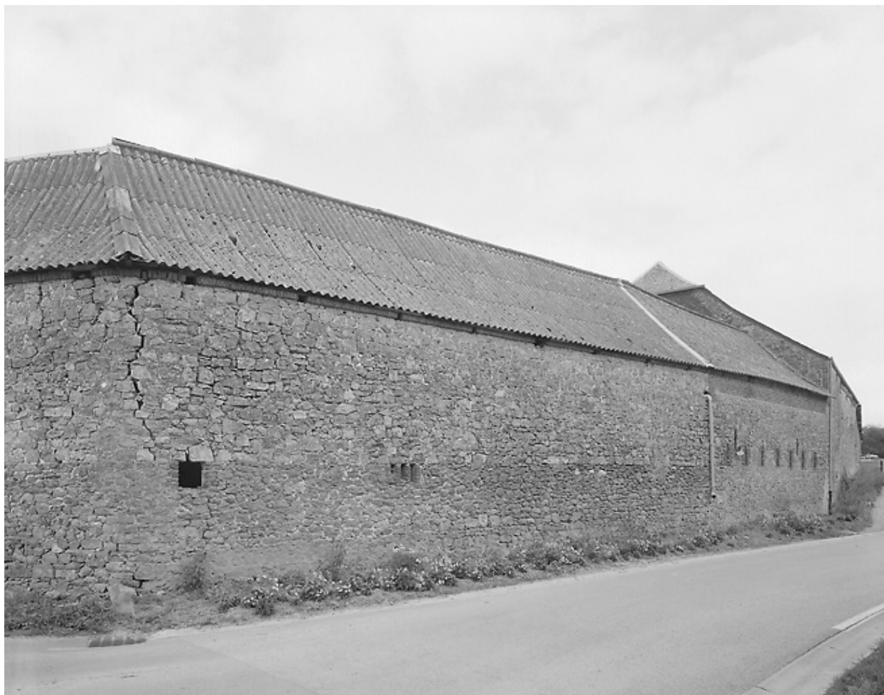
Vue du mur d'enceinte depuis le chemin de Wattignies.
