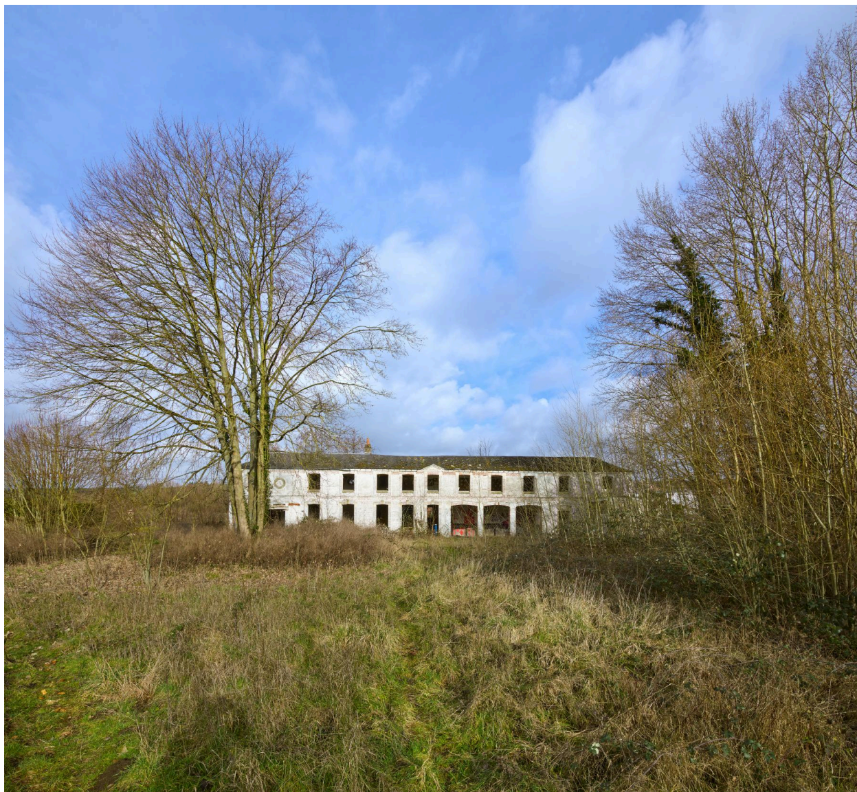
Dépendance du logement patronal, vue générale depuis le logement.
