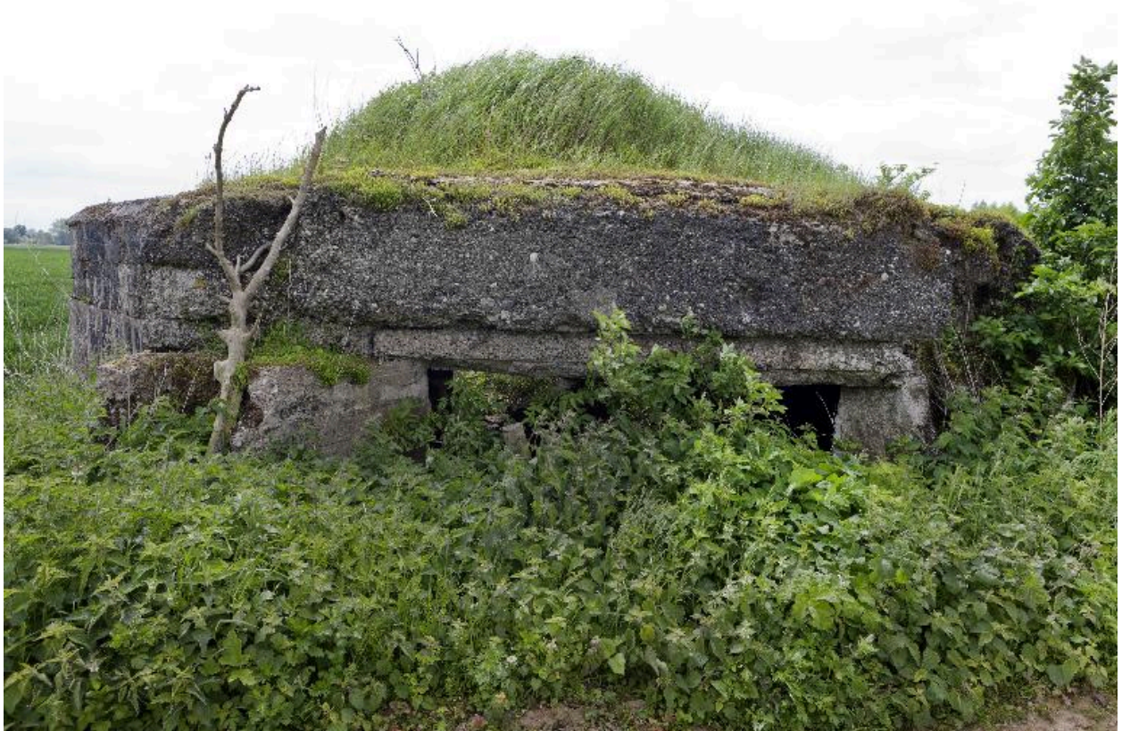
Vue vers le sud-est : sortie de chambre de tir
