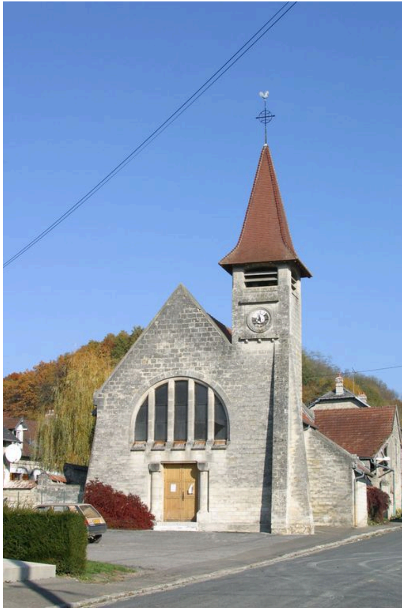
Vue générale de la façade ouest.
