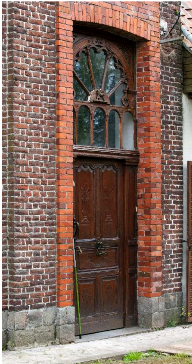
Vue de la porte d'entrée de la maison 14 rue du Maréchal Foch, avec imposte décorée de motifs décoratifs et d'une scène de porteurs de tonneau.
