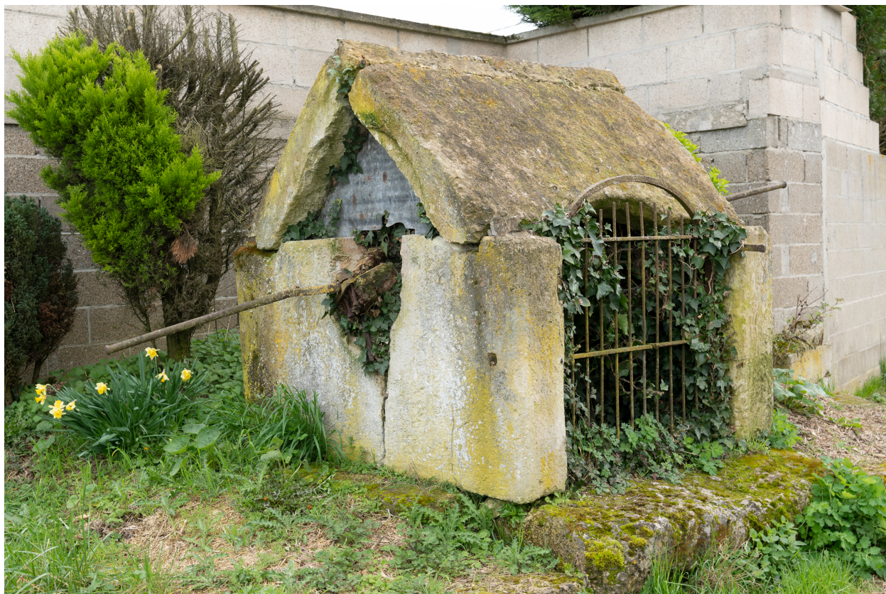
Puits avec son ancienne grille, en face du n°3 de la rue d'Amiens.
