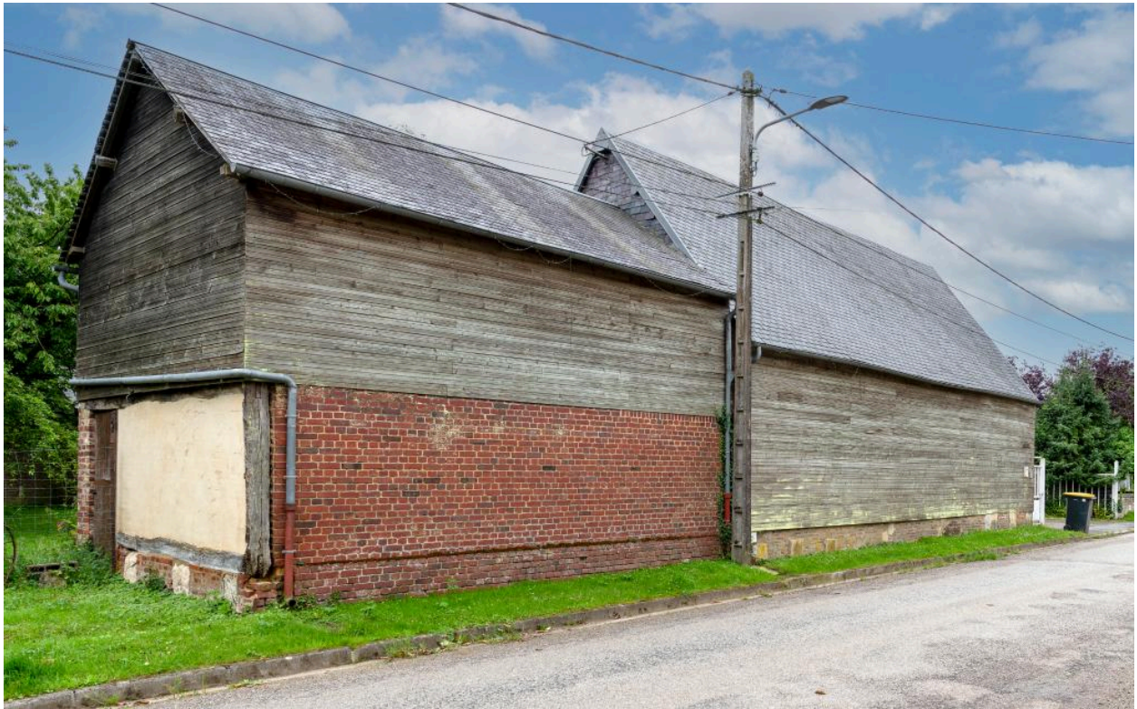
Bâtiments agricoles essentés en clins de bois, n°5 rue de Doméliers, vue depuis le nord-est.
