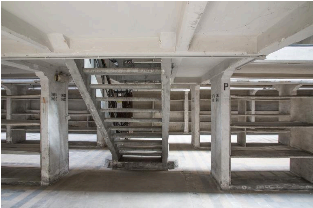
Bâtiment du dépôt, rez-de-chaussée : vue du dessous de l'escalier, vaisseau 3.
