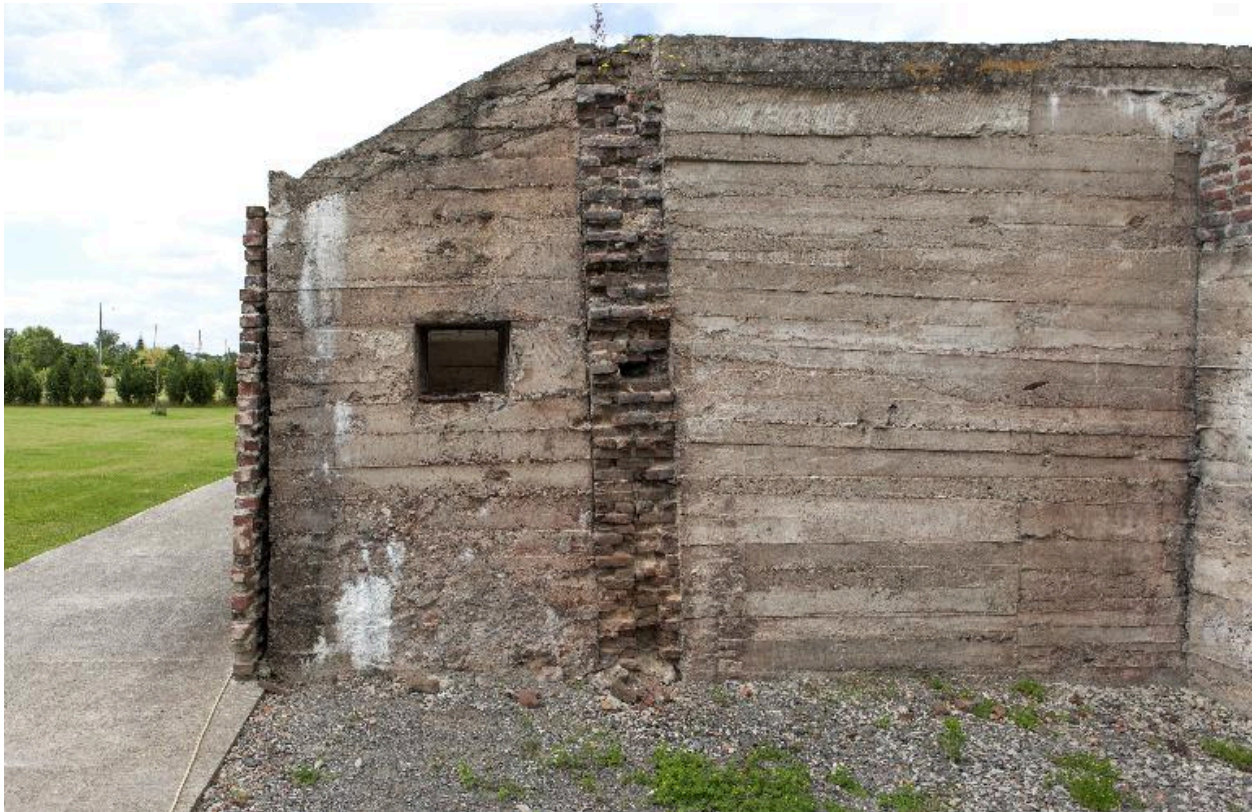
Pignon nord vers le sud-ouest. Détail
