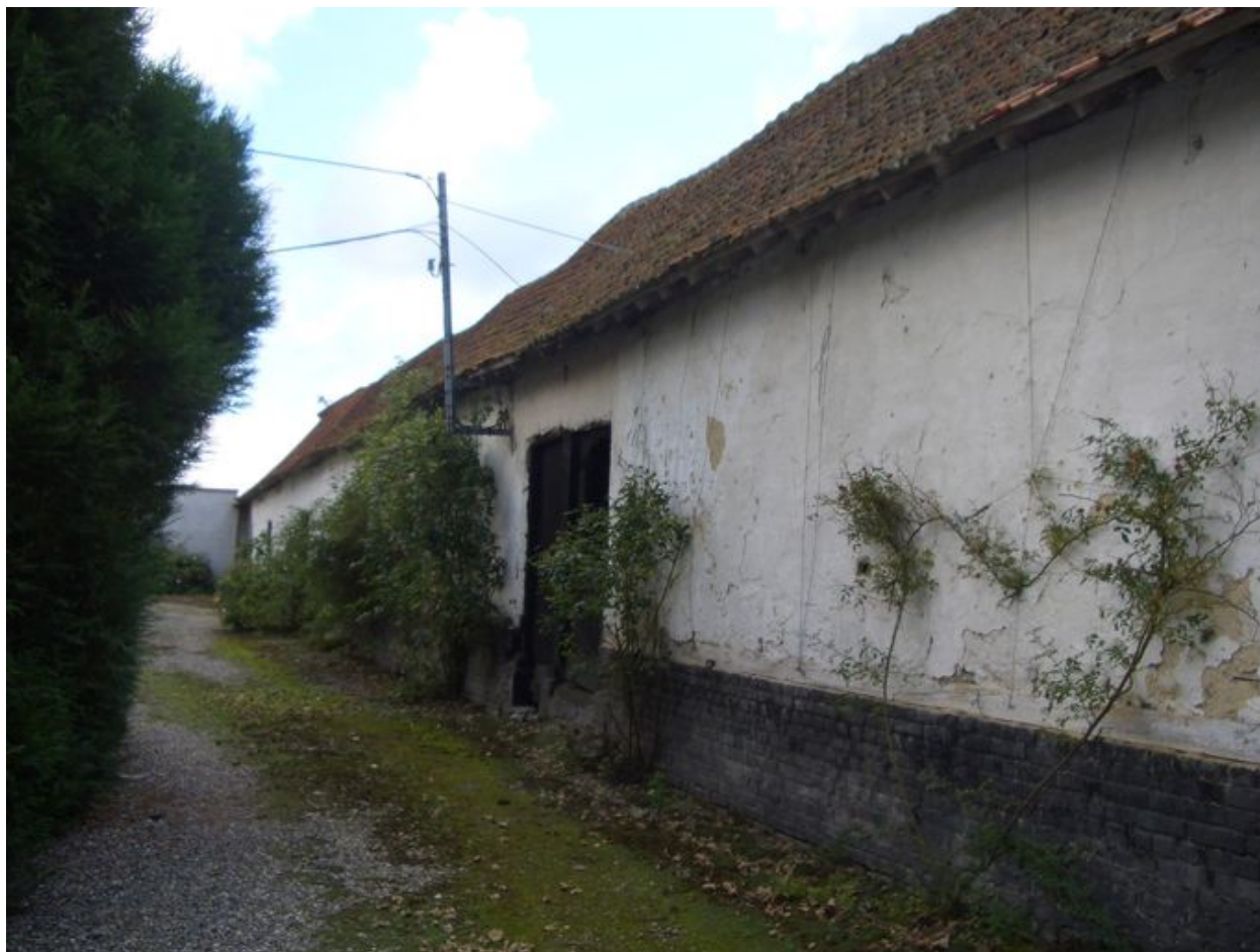
Vue du bâtiment occupant tout le côté ouest de la cour.
